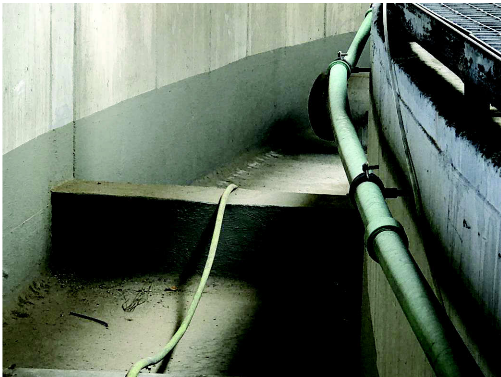
Foto 04: Estanque exterior vacío
