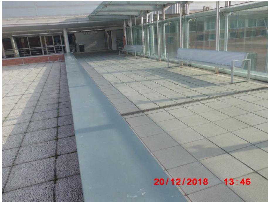
Foto 15: Pasillo lateral Sur.
