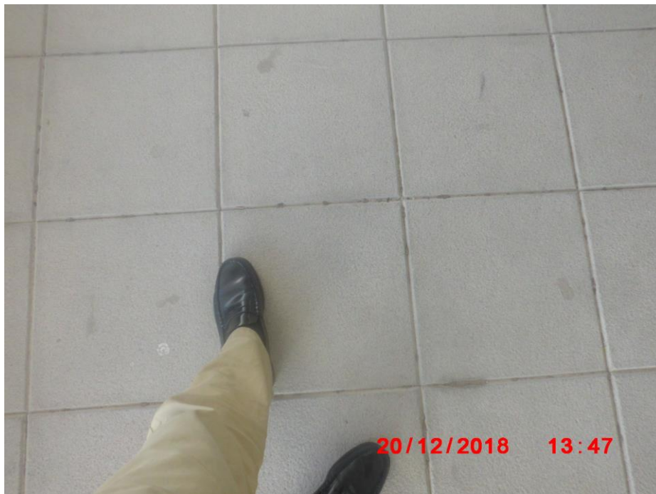
Foto 16: Solado del pasillo lateral.
