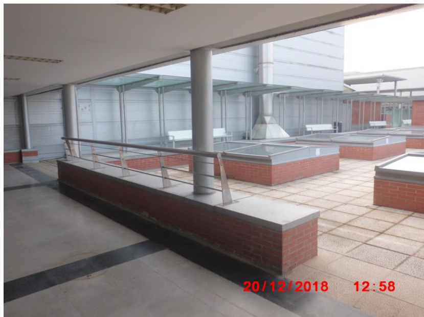
Foto 07: Límite de la plaza de la terraza Sur con el soportal. Peto con barandilla.
