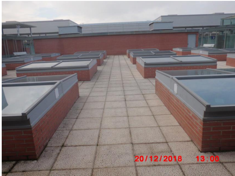
Foto 06: Vista complementaria de la foto 05 de la terraza Sur.
