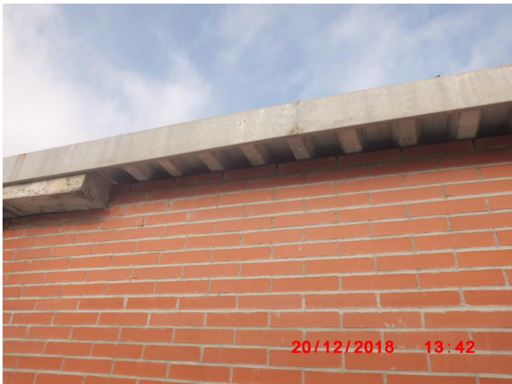
Foto 18: Lateral de la cubierta del cuarto de instalaciones (UTAs) de la terraza Norte.
