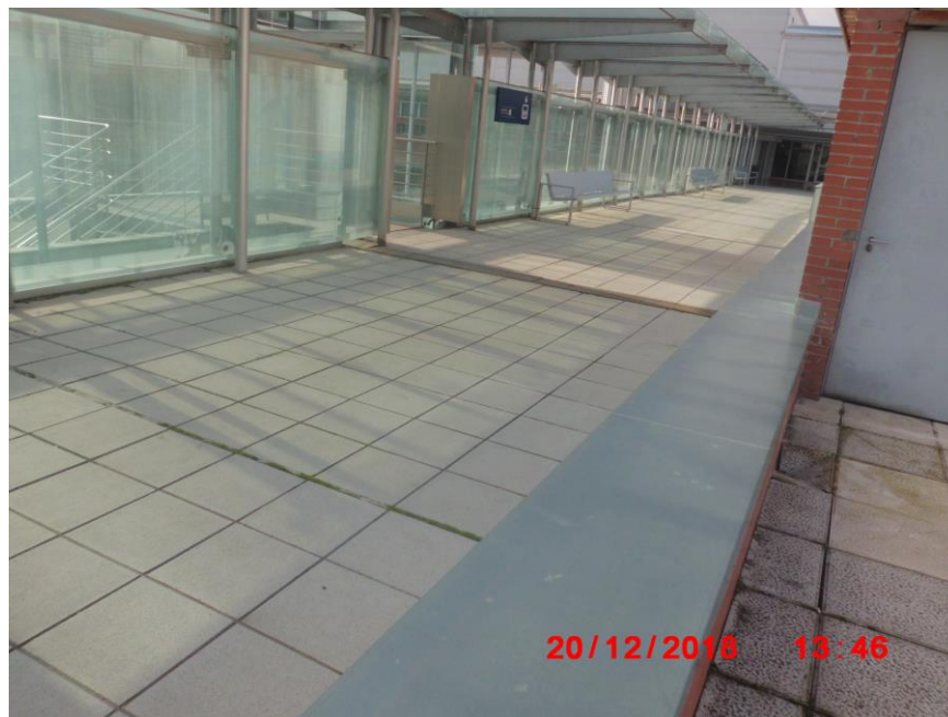
Foto 14: Pasillo lateral Sur.
