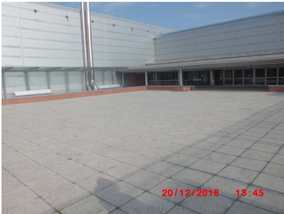
Foto 12: Vista general de la plaza de la terraza Norte, desde el Oeste.
