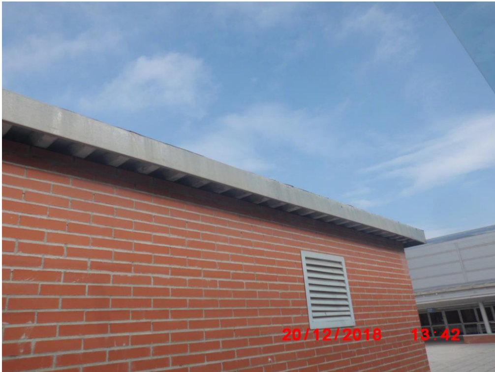
Foto 19: Extremo Este de la fachada Sur del cuarto de instalaciones (UTAs) de la terraza Norte.
