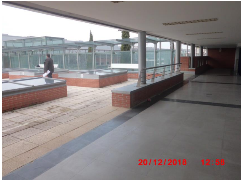
Foto 08: Límite de la plaza de la terraza Sur con el soportal. Peto con barandilla.
