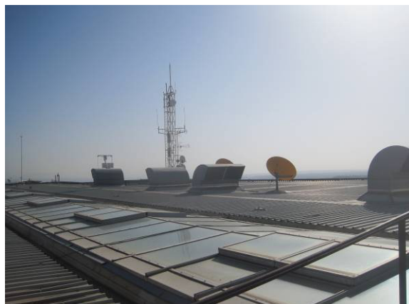
Cubierta, lucernarios y pasarela
