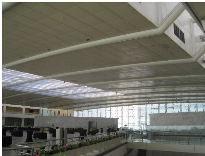
Falso techo del espacio central
