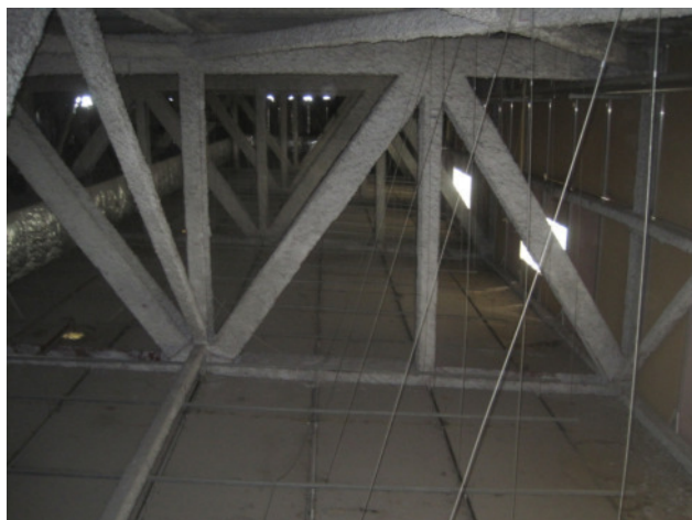
Estructura de cubierta y raíles metálicos que soportan las placas
