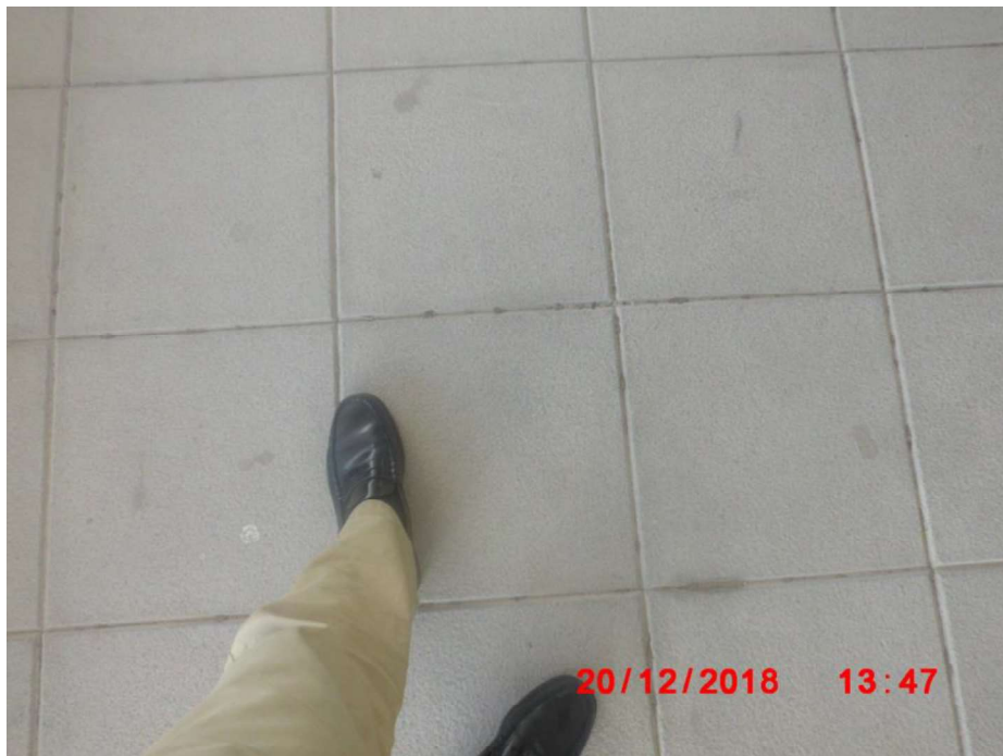
Foto 16: Solado del pasillo lateral.
