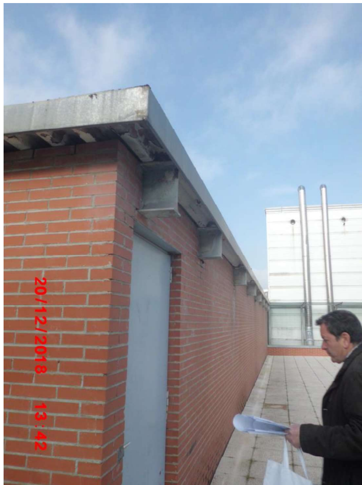
Foto 20: Fachada Este del cuarto de instalaciones (UTAs) de la terraza Norte.
