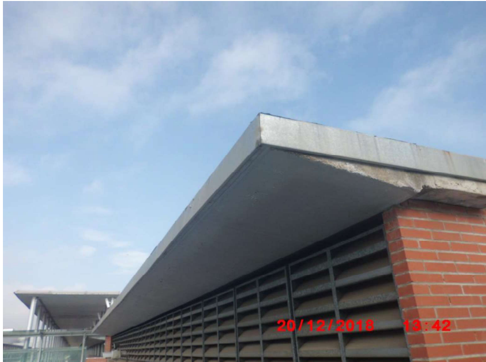
Foto 17: Lado Oeste de la cubierta del cuarto de instalaciones (UTAs) en la terraza Norte.
