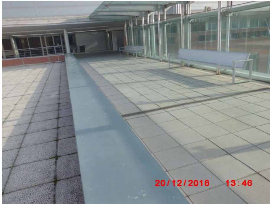
Foto 15: Pasillo lateral Sur.
