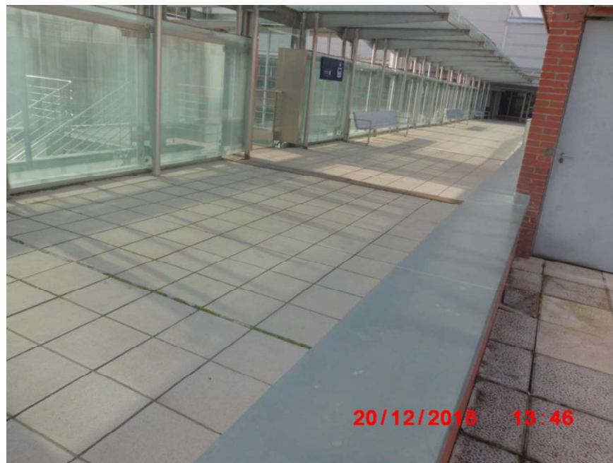
Foto 14: Pasillo lateral Sur.
