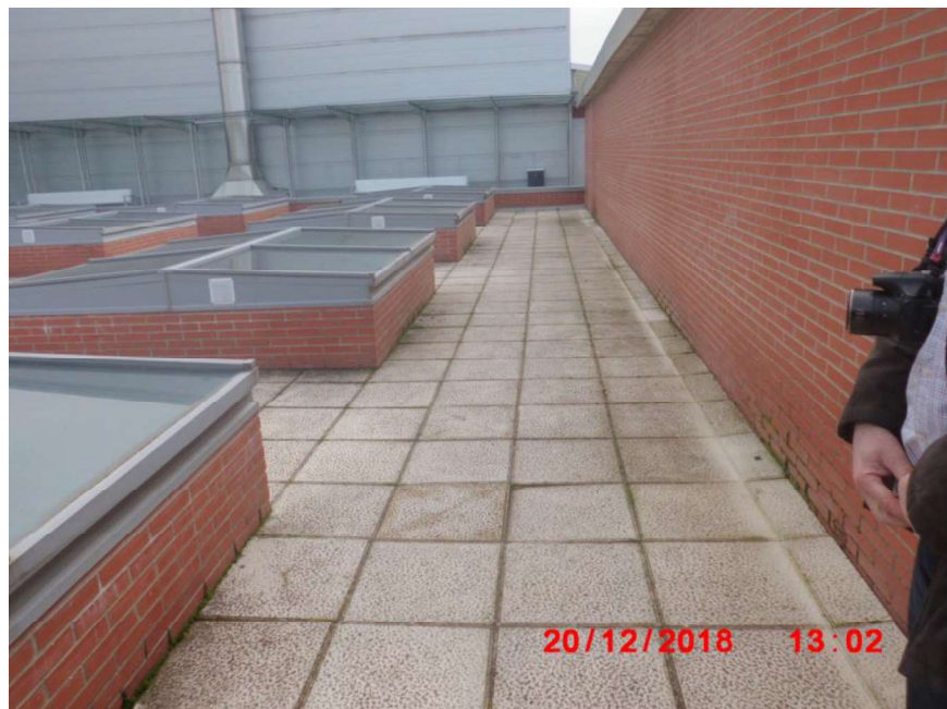
Foto 10: Suelo de la plaza de la terraza Sur.
