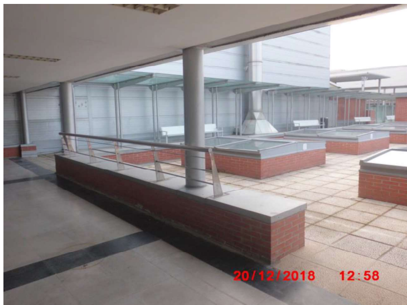
Foto 07: Límite de la plaza de la terraza Sur con el soportal. Peto con barandilla.
