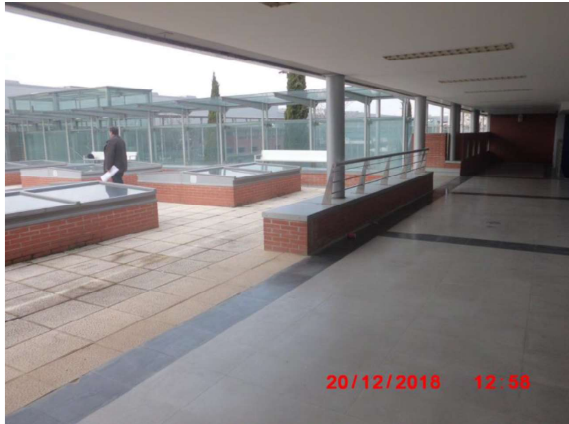
Foto 08: Límite de la plaza de la terraza Sur con el soportal. Peto con barandilla.
