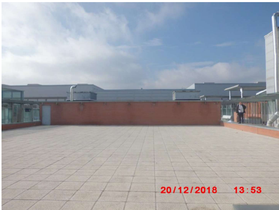
Foto 11: Vista general de la plaza de la terraza Norte desde el Este.
