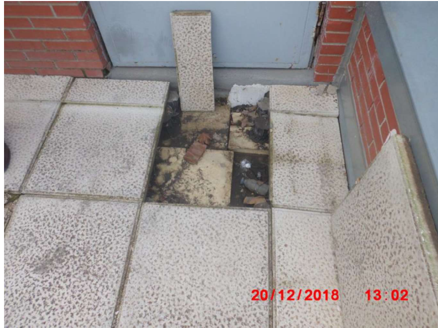
Foto 09: Detalle del suelo de la plaza de la terraza Sur.
