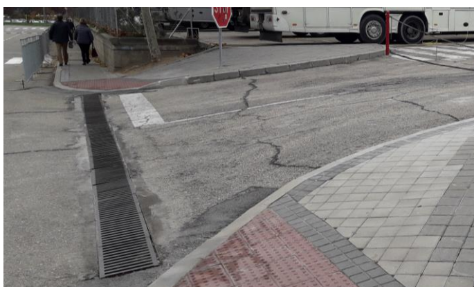
Fotografía nº 9. Acceso parking azul.
