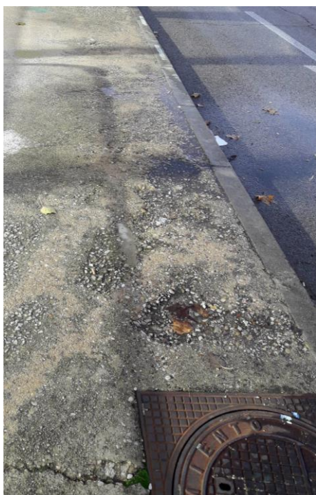
Fotografía nº 2. Acera localizada en zona sureste, frente a Pabellón 2.
