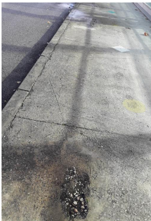
Fotografía nº 1. Acera localizada en zona sureste.
