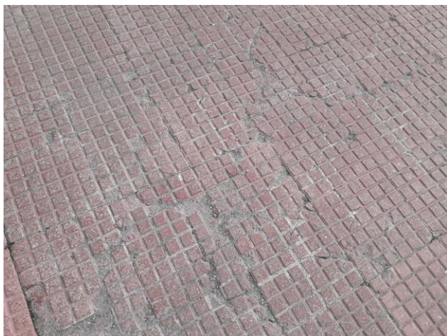
Fotografía nº 10. Acera zona Edificio Puerta Sur.
