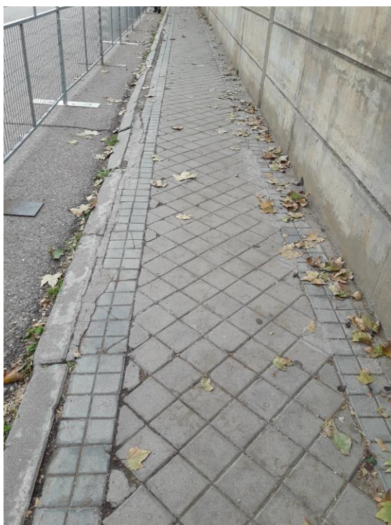
Fotografía nº 6. Acera frente a Pabellón 5.1.
