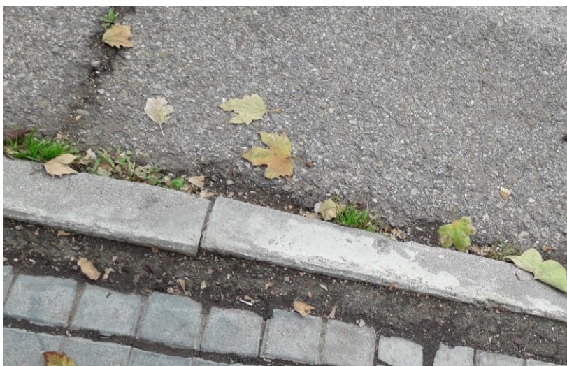
Fotografía nº 7. Acera frente a Pabellón 3.
