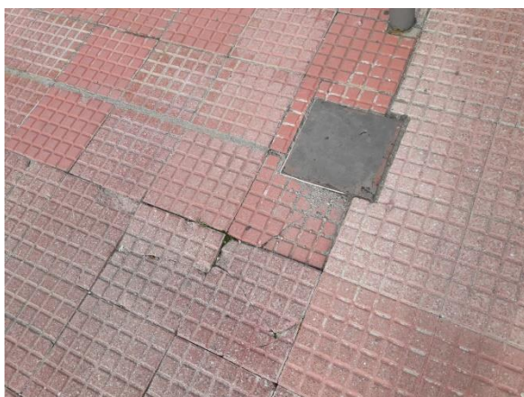
Fotografía nº 3. Acera en zona Edificio Puerta Sur.
