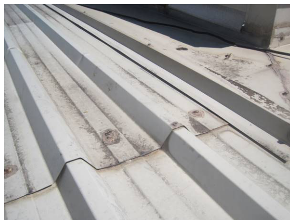
Juntas de sellado de chapas metálicas
