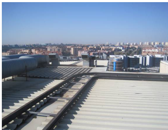
Cubierta chapa grecada, con rail de la máquina de limpieza de fachada
