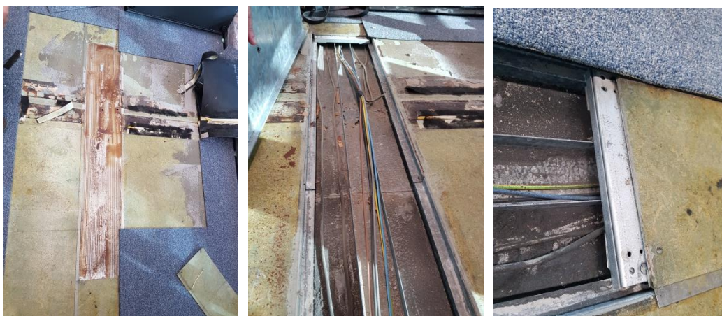
Fotos del estado actual de las canaletas existentes en el forjado.
