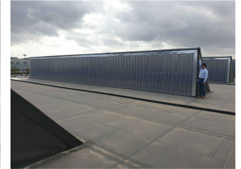
CUBIERTA Y LUCERNARIOS EXISTENTES
