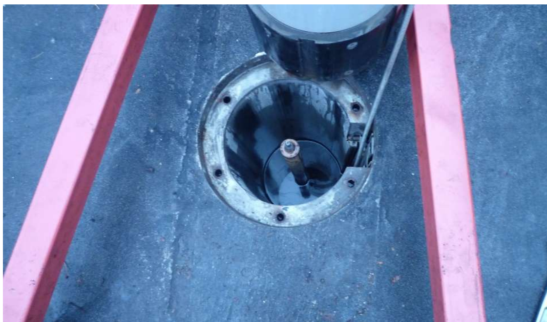
FOTO 8: Agua en el interior de la pizona una vez retirado el cuerpo exterior de la pizona
