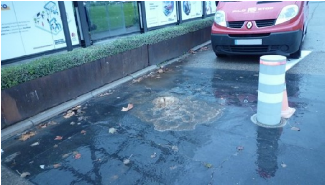
FOTO 1: Salida de agua durante la bajada de la pizona, acceso K1
