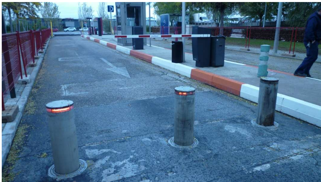
FOTO 12: Fallos de los leds de algunas de las pilonas del acceso K2
