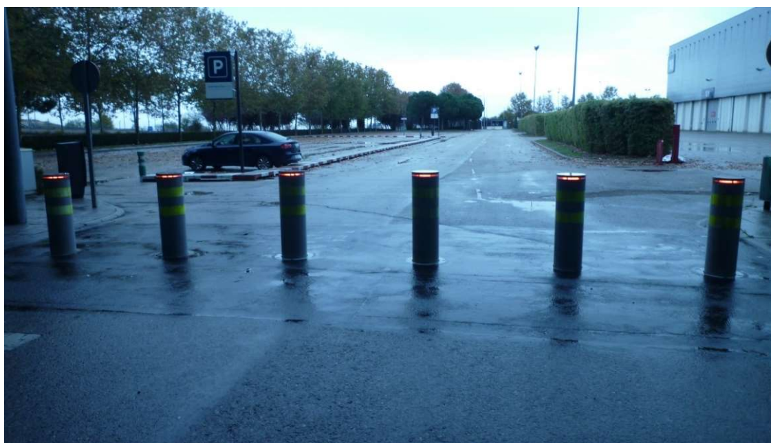
FOTO 15: Prueba de maniobra EFO en la zona de acceso del Centro de Convenciones Norte
