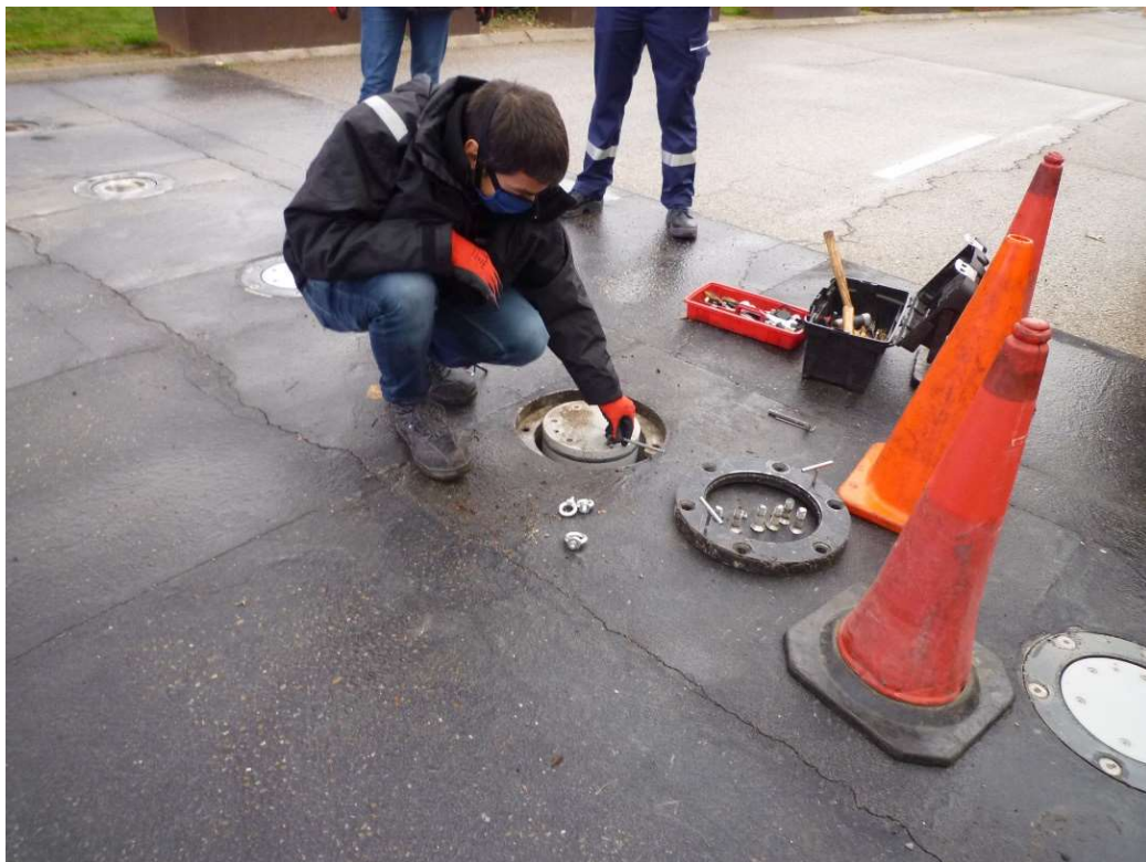
FOTO 6: Corona de pilona desmontada, antes de la extracción de la misma
