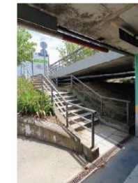
VISTA ESCALERA P.B.
