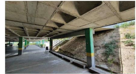
VISTA INTERIOR PLANTA BAJA
