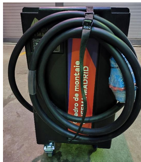
Panel lateral del cuadro con cincha para sujeción de cableado con Marechal y vinilo
