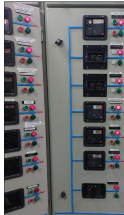
Estado actual de las puertas
