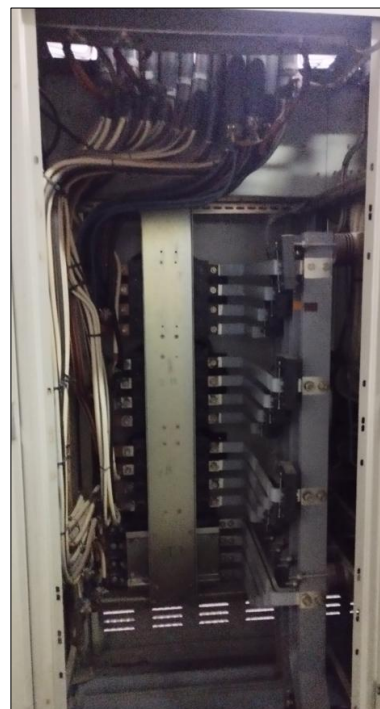
Estado actual del interior
