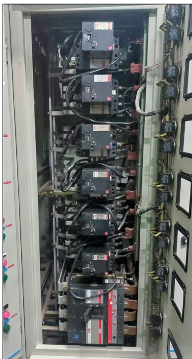
Estado actual del interior
