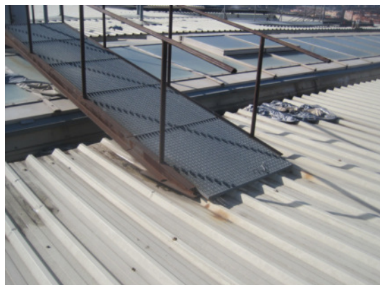
Apoyo de pasarela sobre la chapa grecada
