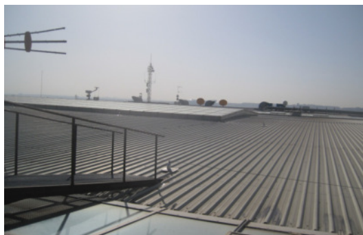
Cubierta, lucernarios y pasarela
