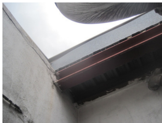
Remate superior patio de instalaciones
