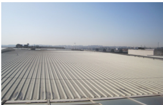
Cubierta chapa grecada
