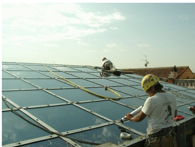
Renovación sellados lucernarios
